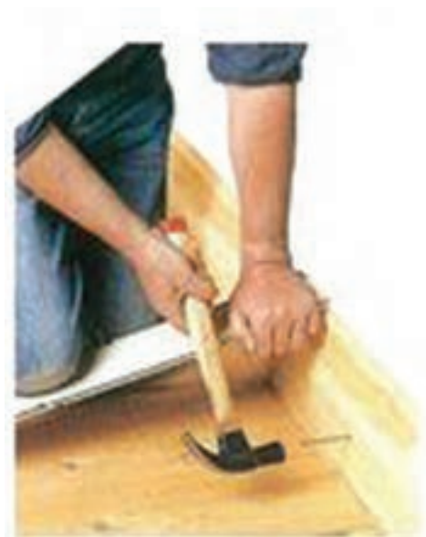
شکل ۳- ۲۹: نصب قرنیز چوبی با میخ
