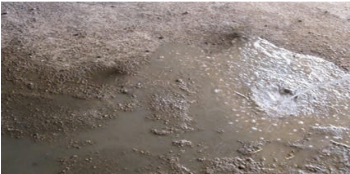
شکل ۱-۶۷: خیس کردن سطح زیر کار
