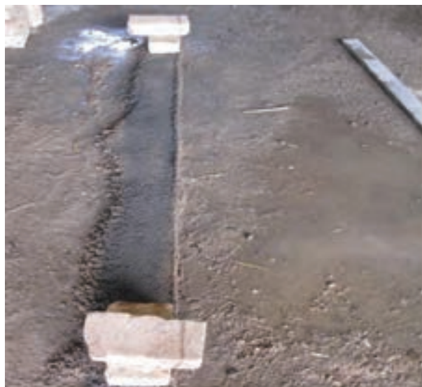
شکل ۱-۷۳: بادخور نمودن ریسمان کار
