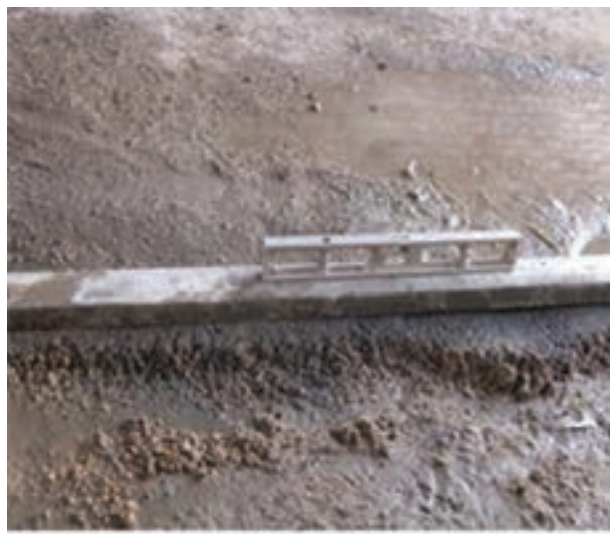
شکل ۱- ۶۹: تراز کردن روی ملات
