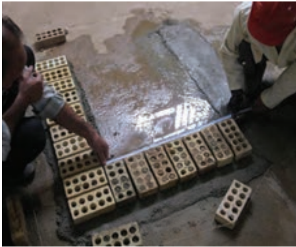
شکل ۱ - ۳۳ (الف): برداشتن طول دیوار
