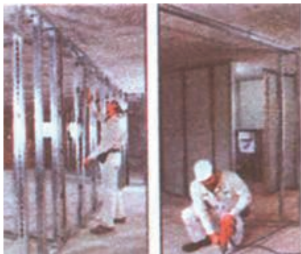
شکل ۱-۴۴: قاب‌سازی جهت اتصال روکش‌های گچی
