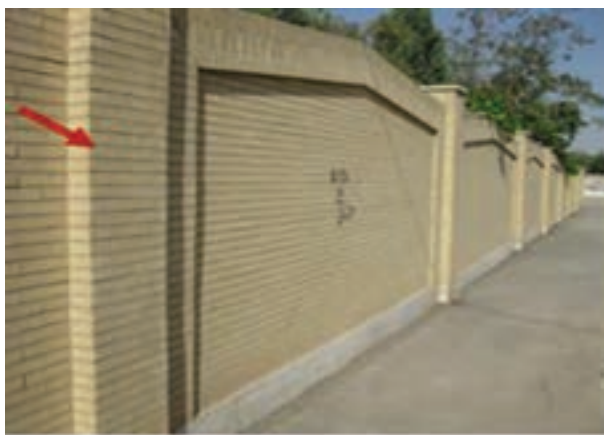
شکل ۱ - ۵۸ : وابند در دیوار حصارکشی
