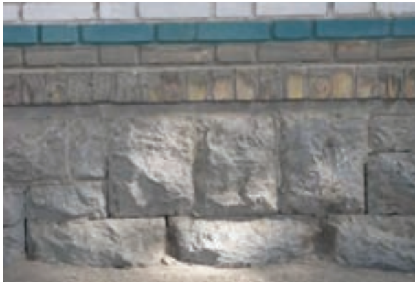
شکل ۱-۱۵ : کاربرد سنگ در پایه های ساختمان
