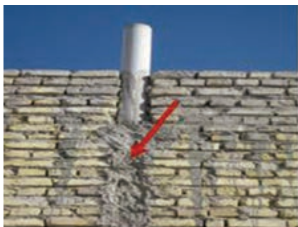
شکل ۱ - ۶۵: پر کردن درز لوله‌ها
