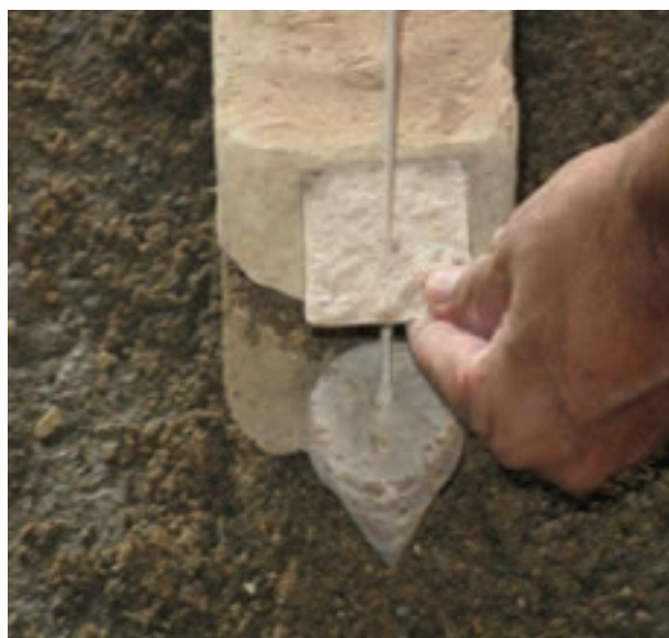
شکل ۱-۹۴: شاقول کردن نبش کار
