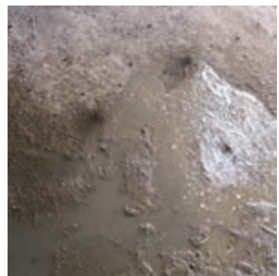
شکل ۱-۱۰۳: خیس کردن سطح زیر کار
