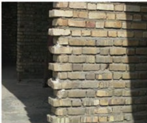
شکل ۱-۵۲: لابند در دیوار آجری
