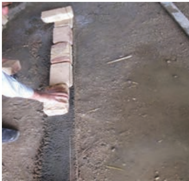
شکل ۱-۹۱: نحوه چیدن آجر در امتداد ریسمان کار
