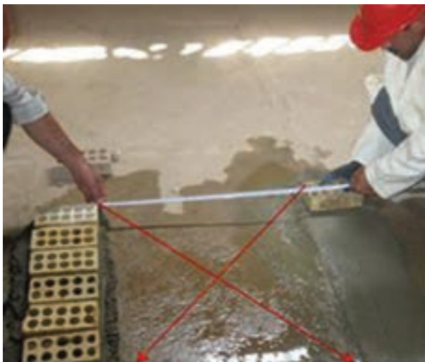
شکل ۱ - ۳۳ (ب): جدا کردن اندازه دو طرف دیگر
