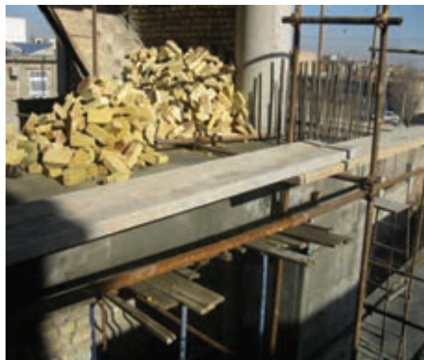
شکل ۱-۲: ضخامت مناسب برای تخته زیر پای
