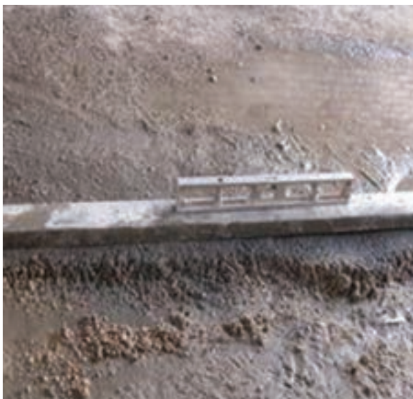
شکل ۱ - ۸۶: کنترل تراز سطح ملات
