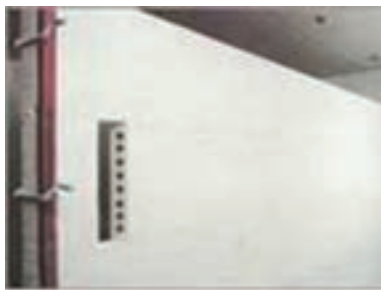
شکل ۱ - ۳۷: دیوار جداکننده با قطعات پیش ساخته گچی
