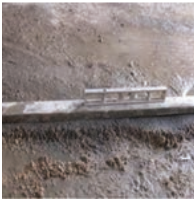
شکل ۱-۱۰۵: تراز کردن روی ملات
