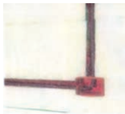
شکل ۱ - ۴۲: لوله گذاری برق در قطعات پیش ساخته گچی
