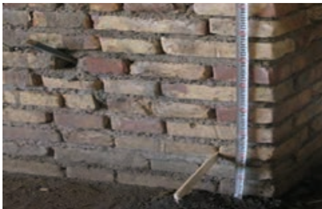
شکل ۳-۳۳: جدا کردن خط تراز روی دیوار
