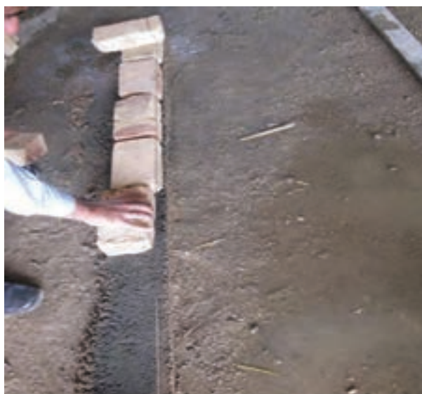
شکل ۱-۷۴: نحوه چیدن آجر در امتداد ریسمان کار
