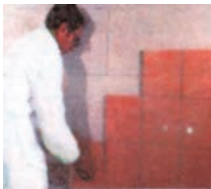
شکل ۱ - ۴۳: نصب کاشی روی قطعات پیش ساخته گچی
