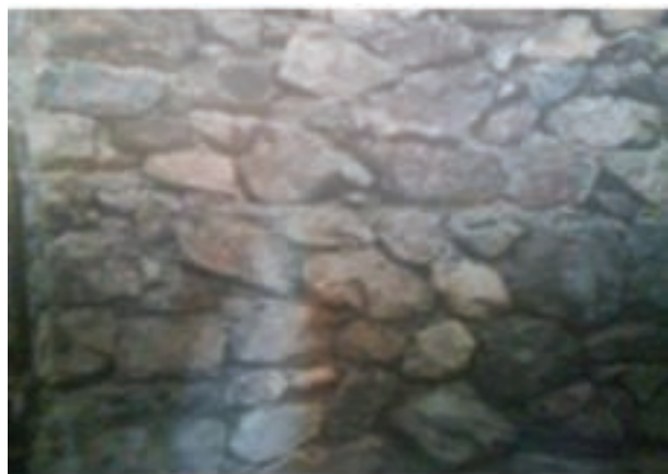
شکل ۱-۲۱: دیوار باربر
