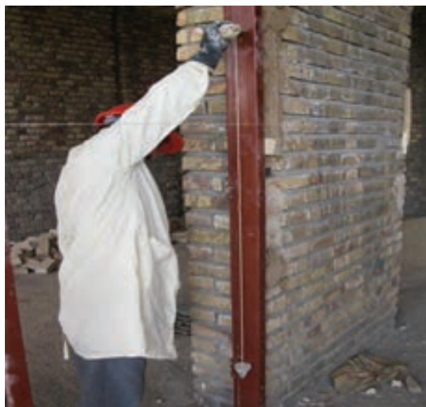
شکل ۳-۲۳: شاقول کردن وادار
