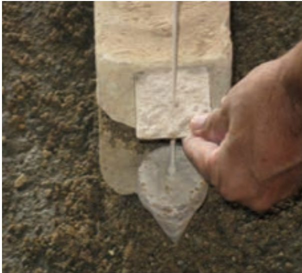
شکل ۱- ۷۷: شاقول کردن نبش کار
