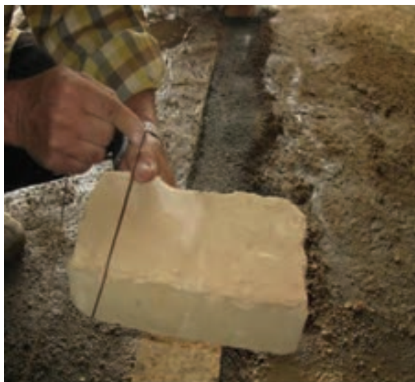
شکل ۱-۷۲: نحوه بستن ریسمان کار به آجر
